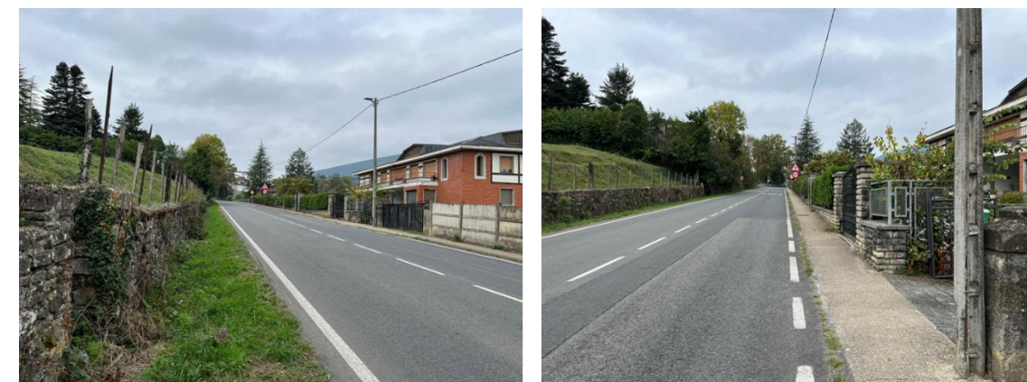
Carretea A-624 en su primer tramo
