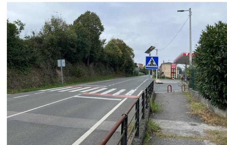
Conexión de ambos márgenes por paso de peatones para acceso a parada de autobús
