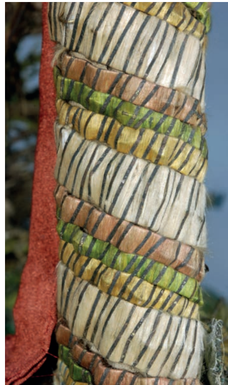
Fig. 11. CI2: tiras entorchadas envolviendo la estructura de una columna.
