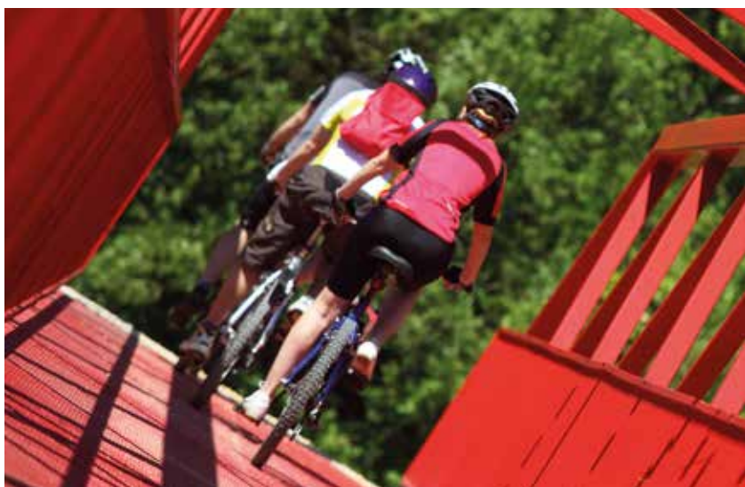
Pasarela en la Vía Verde del ferrocarril Vasco-Navarro
