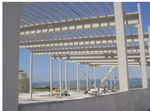
Instalazioaren eraikitze-lanen ikuspegia
