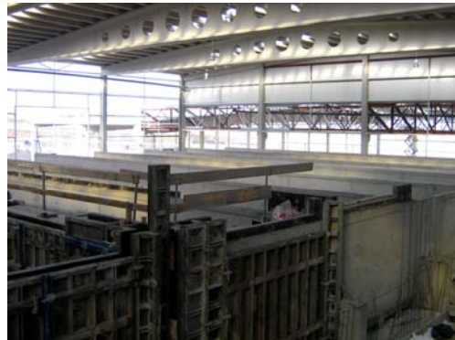
Vista de las trincheras en construcción
