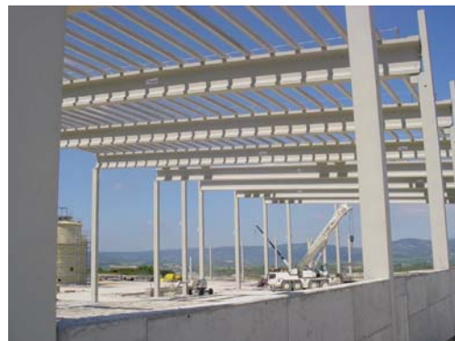
Vista de la construcción de la planta
